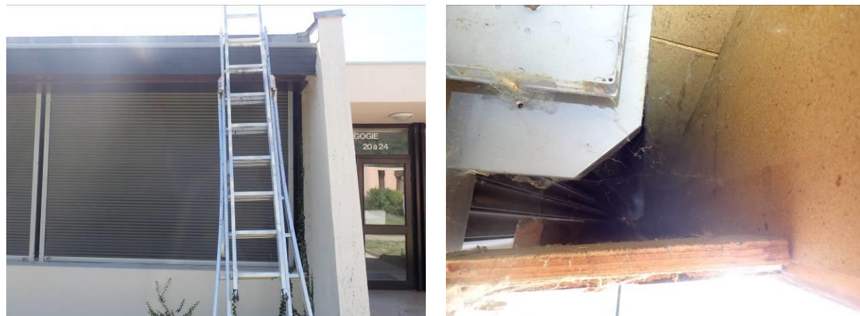
Illustration 8 : Inspection des bâtiments : intérieur d'un volet roulant
